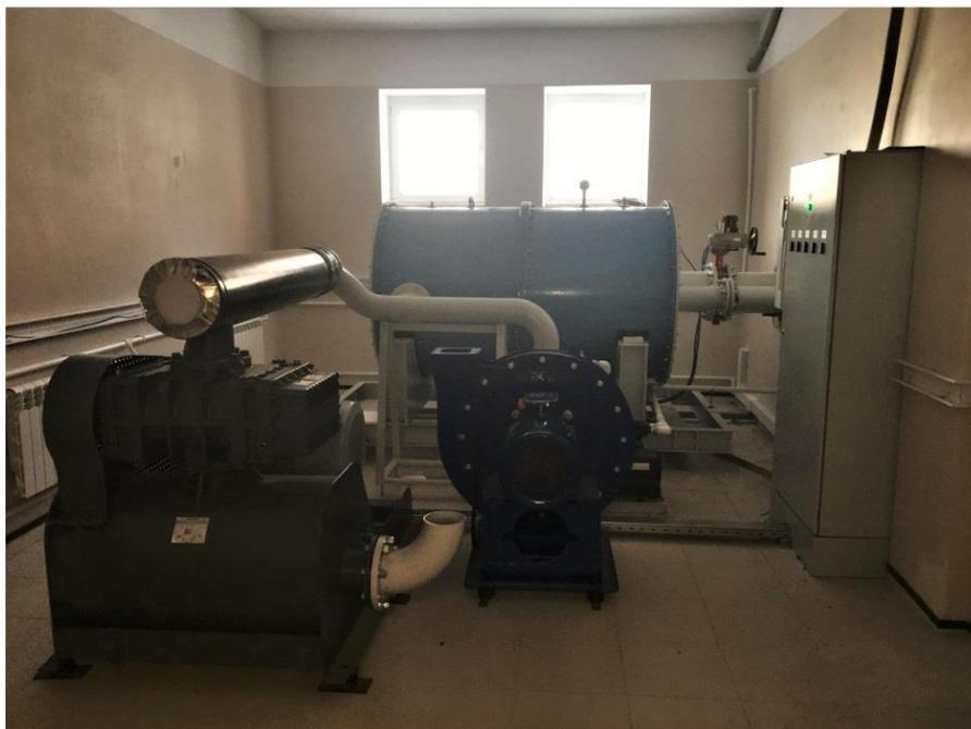
Рисунок 1 – Общий вид установок поверочных газовых «Аврора» модификации N на базе критических сопел Лавалья
